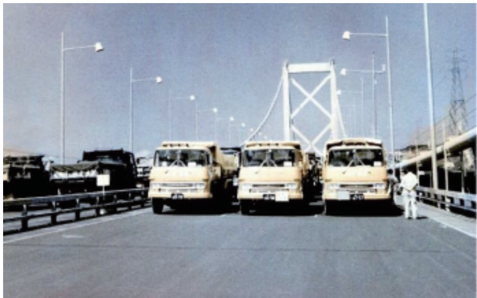
1973年、関門橋開通試験に協力する住吉運輸のダンプ約30台
