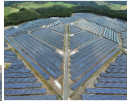
宮城県白石市太陽光発電施設所造成工事
